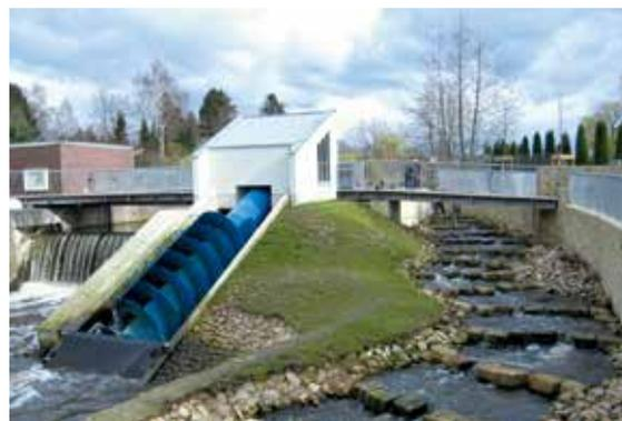
Wasserkraftschnecke an der Bochalter Aa, Leistung 50 kW
