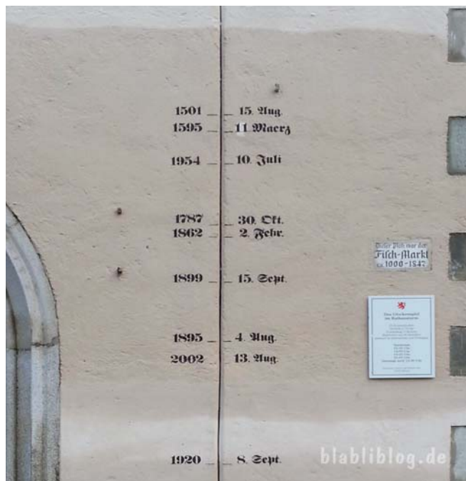
oben Historische Wasserstandsmarken am Rathaus in Passau. Vernässter Mauerbereich als Folge des Hochwassers 2013 zeigt einen Wasserstand weit über der Marke von 1501.
