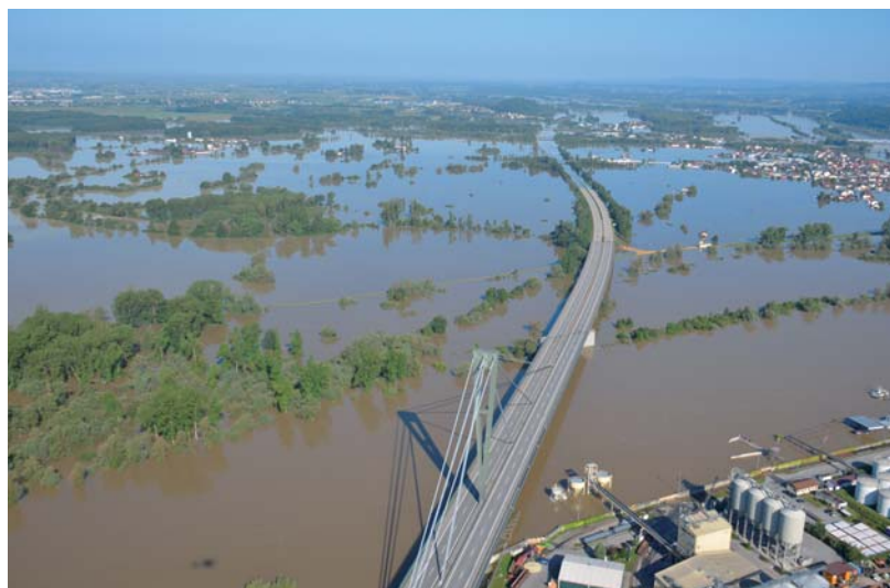
oben Verkehrsadern unter Wasser: blockierte Infrastruktur, wie hier bei Deggendorf, führt zu hohen indirekten Schäden.
